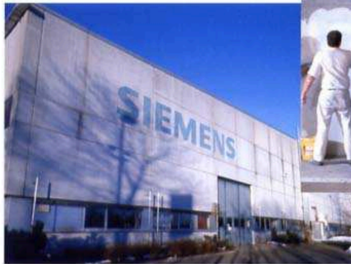
Mit 17,5 cm KS protect® abgeschirmt gegen Röntgenstrahlen: Medizintechnisches Zentrum in Kemnath
